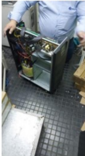
UPS EN MANTENIMIENTO
